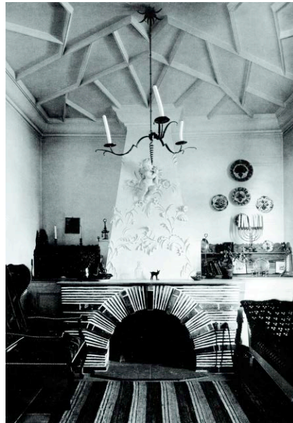
Der Kamin wurde nach alten Fotos in schlichterer Ausführung rekonstruiert, auch die Diele kommt ihrer alten Fassung nahe. Die Hauptarbeit lag auf der denkmalgerechten Ausführung. So wurden z. B. Gartenspaliiere statt mit Dübeln mit nachgebildeten Blechdornen an der Mauer befestigt. Um beim Streichen der Fenster wieder scharfe Kanten zu erhalten, wurde der satte Anstrich nach dem Lackauftrag mit der Spachtel abgezogen. Rechte Seite: typische Schadensbilder vor der Sanierung
